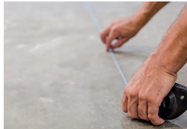
Set the guideline | Plantea la línea maestra | Établir la ligne principale | Spannen Sie die Richtschnur
